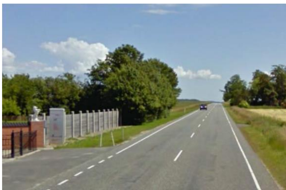
2-sporet vej med 10 cm kantlinje før ændringen af afmærkningen.
