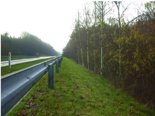
Autoværn på skråningstop.
