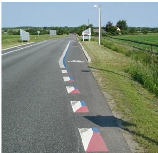
Indsnævring af kørebane med 3D afmærkning.
